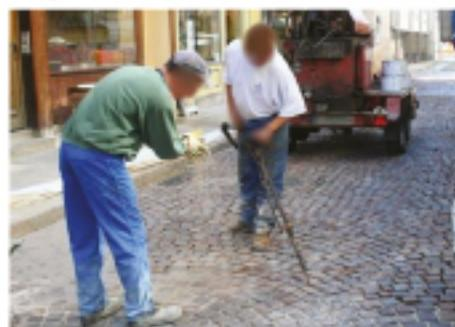
Juste après le coulage du Shell Mexphalte C joint P3J, répandre du sable de quartz séché (granulométrie 0.6 à 1.2 mm) sur le Shell Mexphalte C Joint P3J encore chaud.
