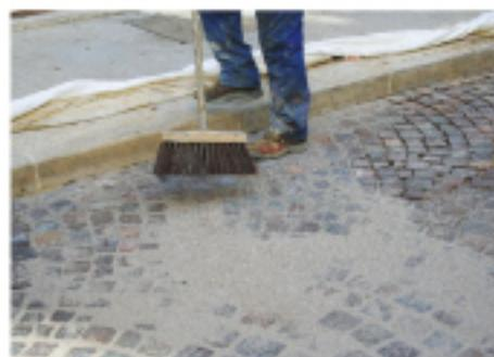
Aussitôt le répandage de sable réalisé, balayer le surplus.
