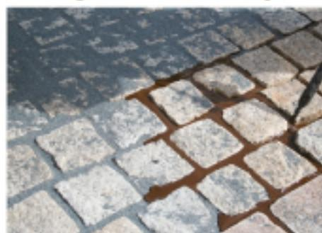
S'assurer que le mastic dans le fondoir est homogène et à une température comprise entre 120 et 140 °C. Le produit, à la sortie du malaxeur, doit être mis en œuvre :
