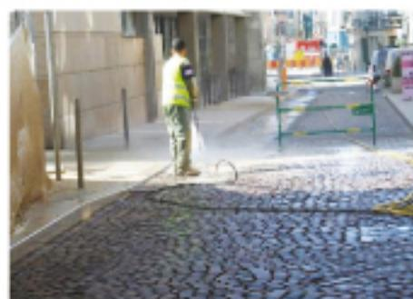
Dégarnir les joints sur une hauteur de 30 mm minimum au jet d'eau ou à l'air comprimé (suivant le degré de compactage du sable).
